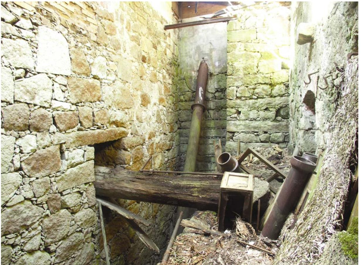
... und zeigt im Inneren noch interessante Details, wie die Radkammer mit Welle und Fallrohr ...
